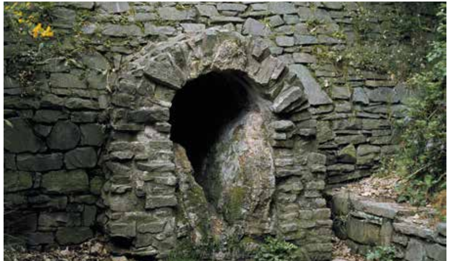
Aufschluss der Eifelwasserleitung bei Kreuzweingarten mit 30 Zentimeter starken Kalksinterablagerungen.
